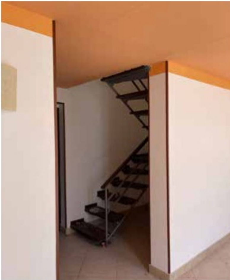
Foto n.07 Vista della scala interna in ferro che collega il piano terra con il primo soppalcato
